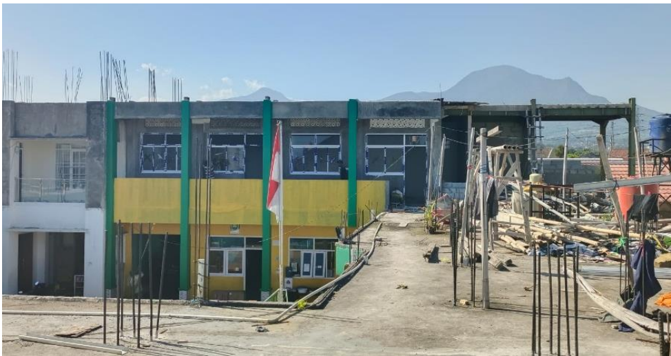
Gambar 1. Proses Pembangunan di Pondok pesantren Alkhawarizmi
